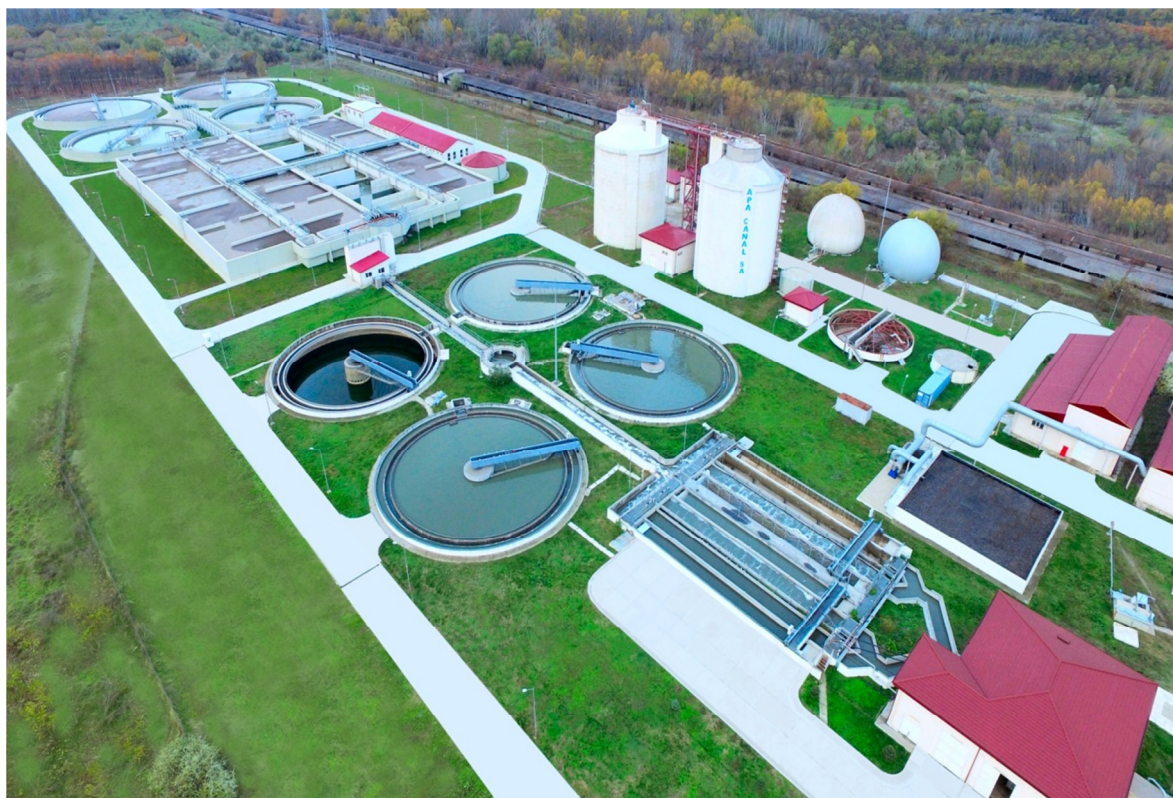
Statia de Epurare Ape Uzate Galati
