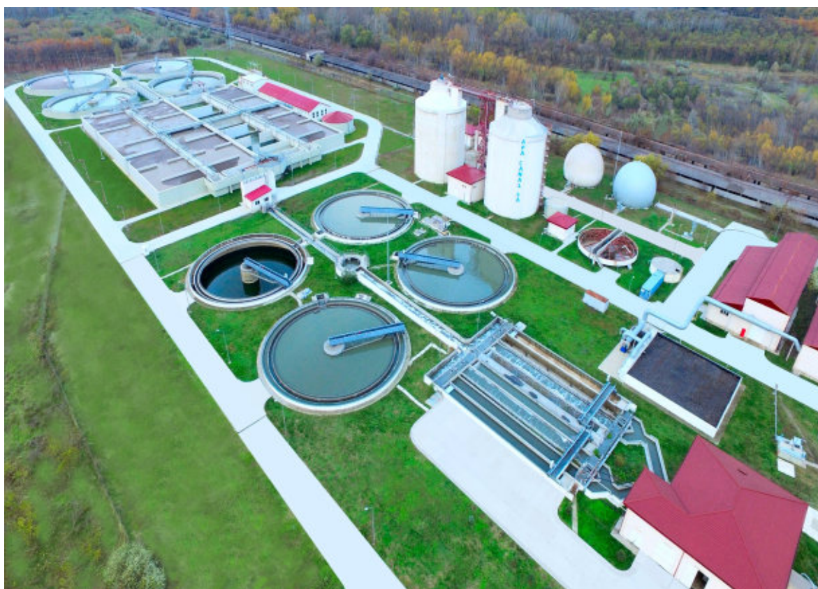
Statia de Epurare Ape Uzate Galati
