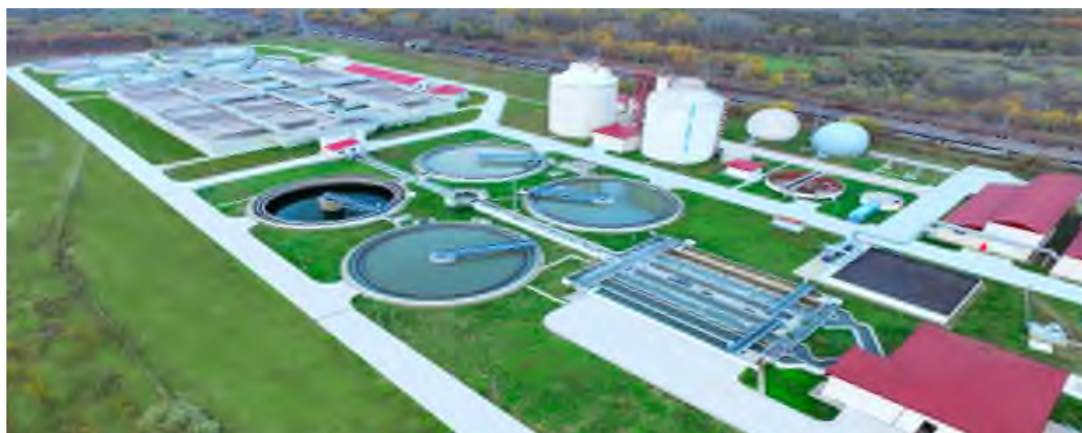
Statia de Epurare Ape Uzate Galati
