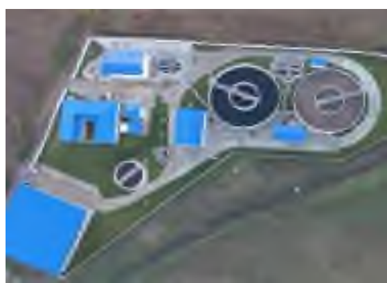
Statia de Epurare Pechea
