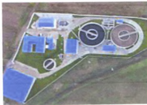
Statia de Epurare Pechea
