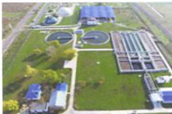
Statia de Epurare Tecuci
