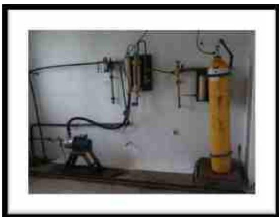
**Figura nr. 2.19.14-24** Instalație de dezinfecție cu clor gazos
