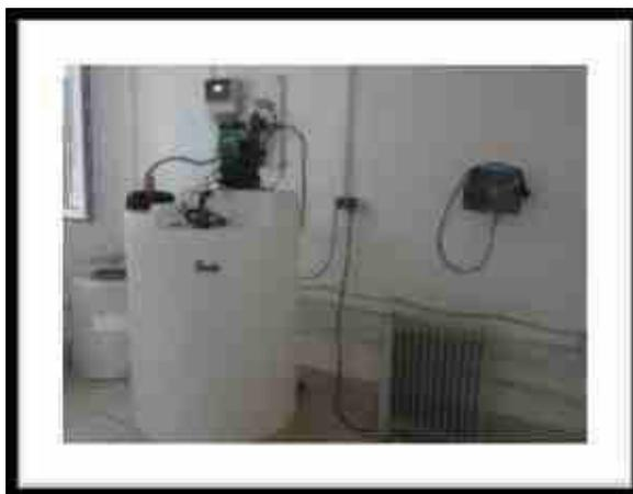
**Figura nr. 0-12 Stație de clorinare la gospodăria de apă Ivești**
