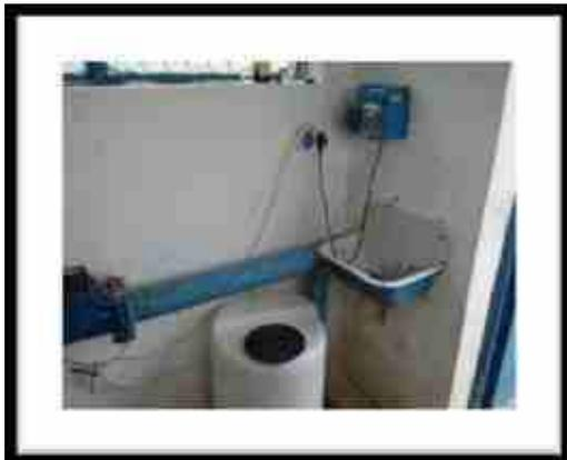
**Figura nr. 0-8 Instalație automată dezinfecție – Gospodăria de apă Berești**
