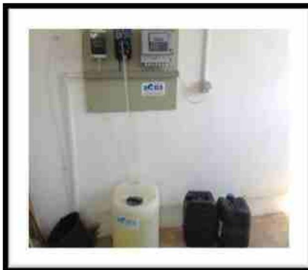
**Figura nr. 2.19.11-3 Stație de clorinare Hanul Conachi**
