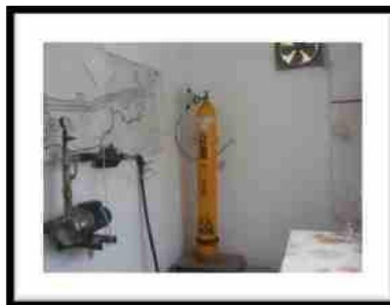
**Figura nr. 2.19.14-25** Instalație de dezinfecție clor gazos Gospodăria
