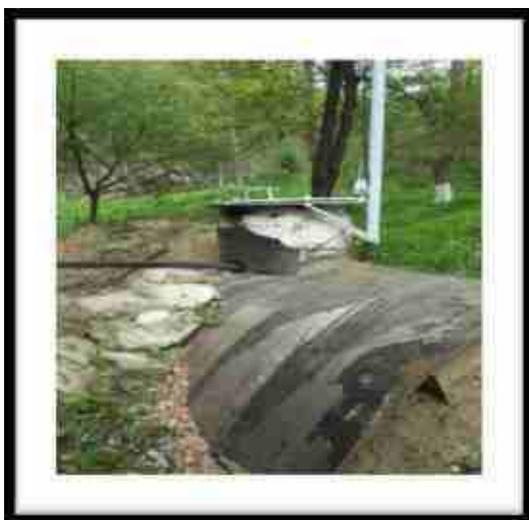
**Figura nr. 0-9 Rezervor metalic 20 mc – front captare**
